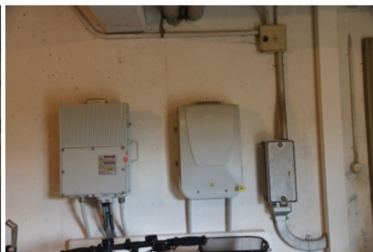
ZCH1-022 6: Glasfaser/Telefonverteilung
